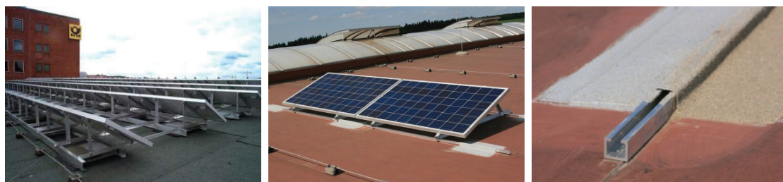
Figur 10: Tv.: Almindelig montering af solcelleanlæg på tagpaptag med betonplader. Midt og th.: Montage med balastfri klæbemontage.
